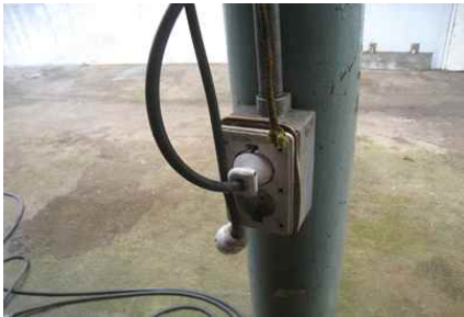
옥외 일반콘센트 설치
