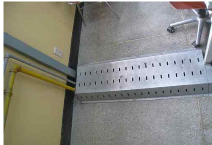
가스배관 보호덮개 설치(예)
