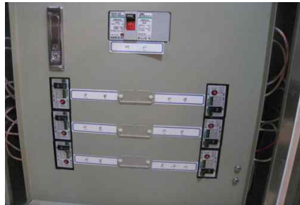
도어형 안전속판 설치(예)
